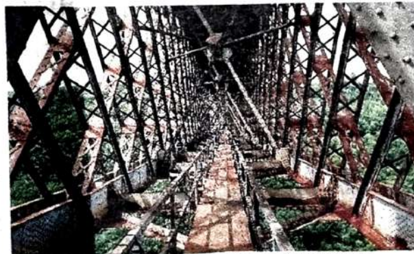
Dans le Puy-de-Dôme, le vieillissant viaduc des Fades pourrait devenir un terrain d'expérimentation « grandeur nature » et servir de démonstrateur. PHOTO J.-P. MUZEAU
